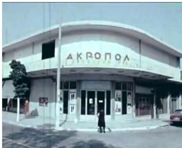
Το σινεμά Ακροπόλ το 1977. Πλέον είναι κατάστημα Κωτσόβολος
